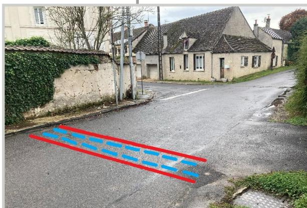
Cet ouvrage hydraulique collecte les eaux drainées des champs agricoles et permet leur traversée sous la route. Souvent encombré de terre et de sable, l'écoulement des eaux est ralenti, voire stoppé, provoquant des débordements sur la chaussée. Pendant le renforcement, un piège à sable a été aménagé pour retarder ces dépôts.
